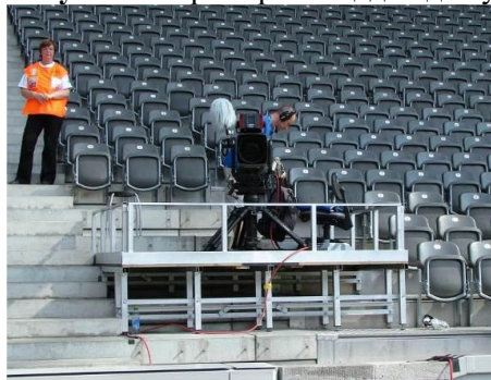
Рисунок 8. Пример площадки для установки телекамер.
