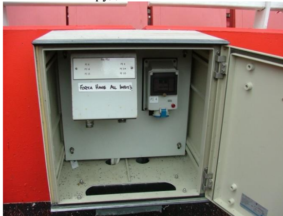
Рисунок 5. Примеры шкафов подключения телевизионного оборудования.
