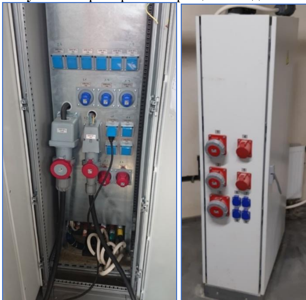
Рисунок 4. Примеры электрощитов подключения ПТС.
